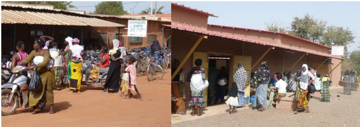
Die AMPO-Krankenstation vor und nach der Renovierung.
